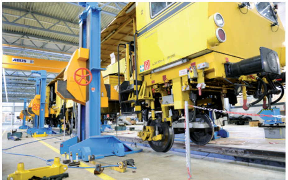
Abb. 4: Modern ausgestattetes Instandhaltungswerk in Leverkusen/Opladen
